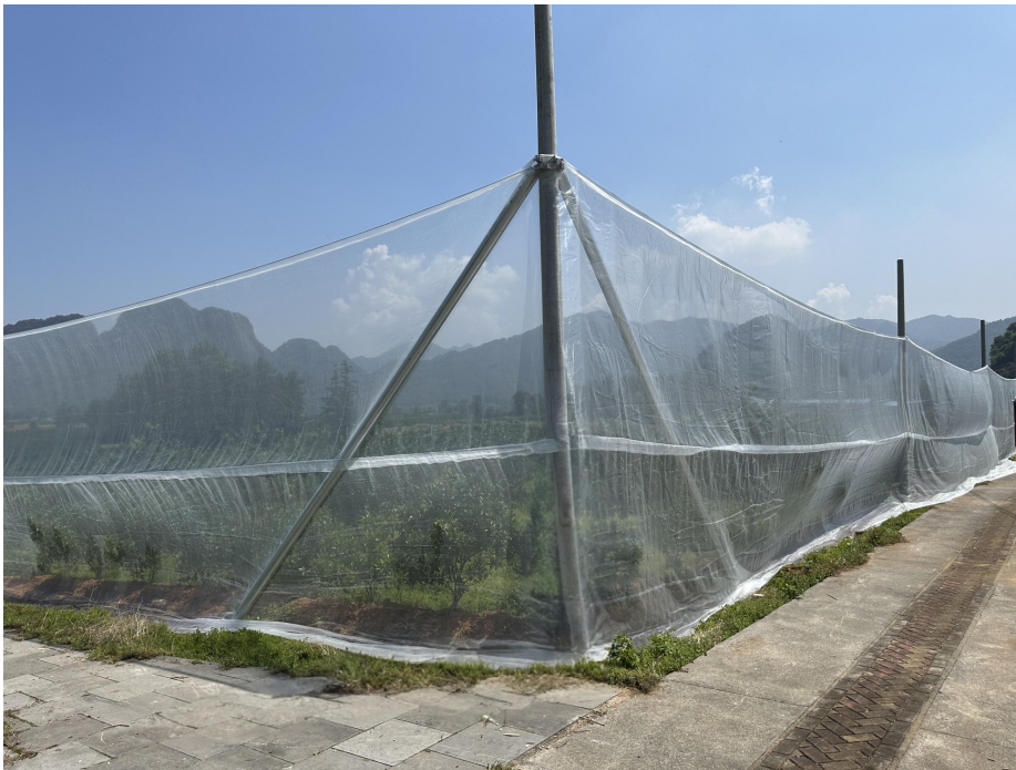
图 A. 2 水泥电线杆作为支撑立柱的防虫网墙
